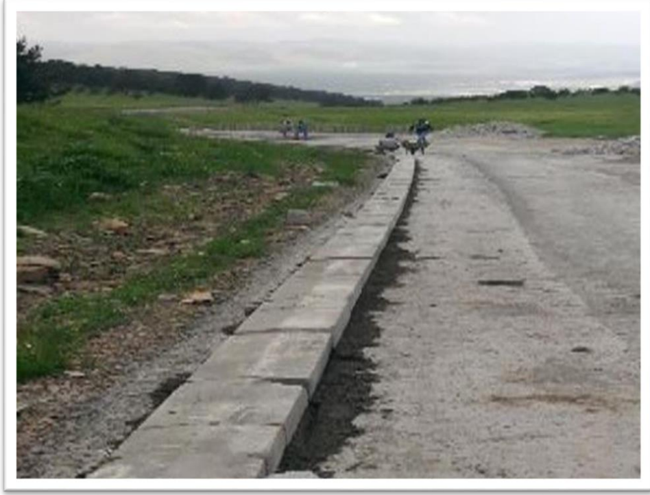
Resim 2.12. Sarıkamış Kızılçubuk Deresi Taşkın Koruma-1 İlçe taşkından korunmuştur (Sarıkamış Şehitliği yürüyüş yolu) (DSİ,2021)
