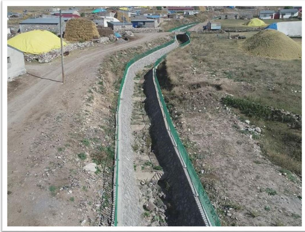
Resim 2.11. Kars Merkez Ağadeve Köyü Taşkın Koruma-1 köy taşkından korunmuştur (DSİ,2021)
