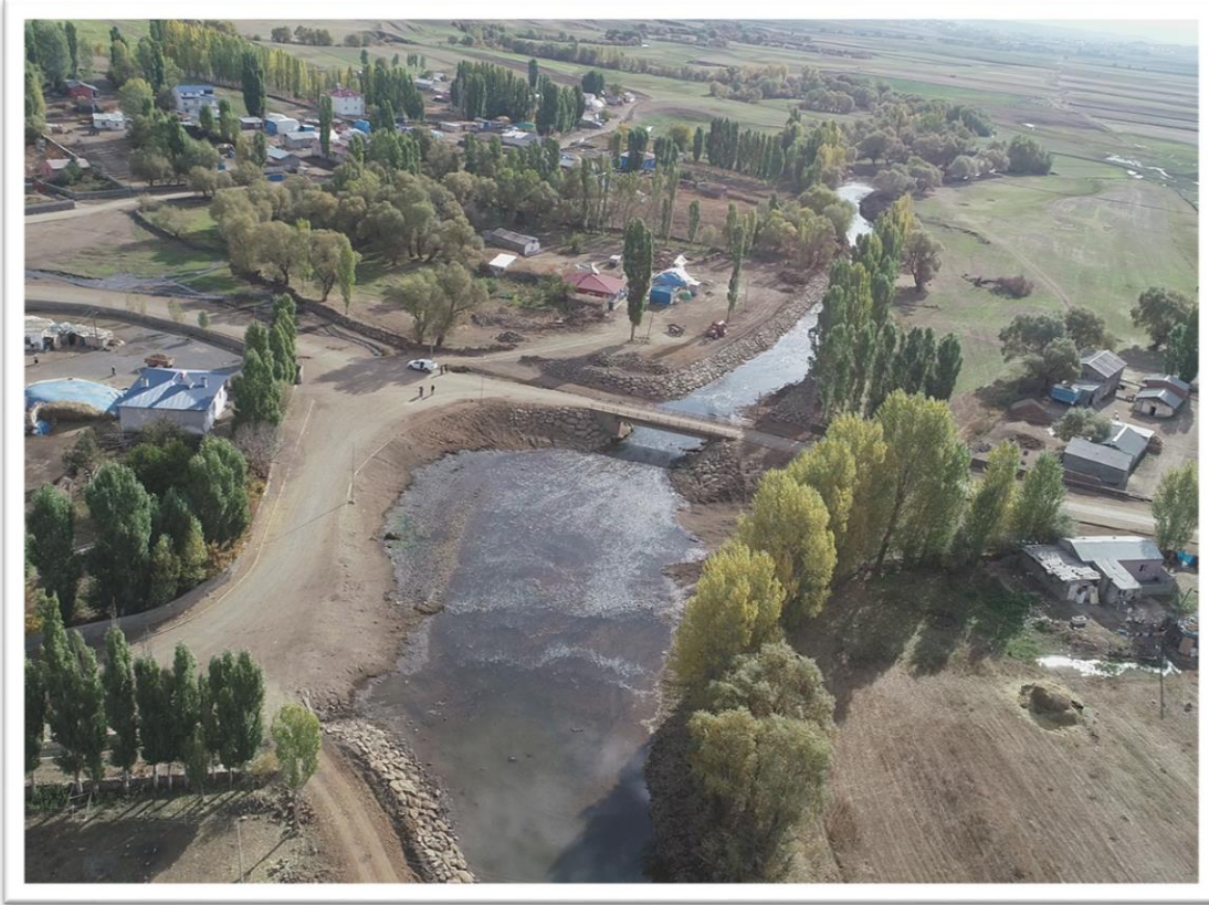
Resim 2.13. Kars Susuz Aynalı Köyü Tersip Bendi ve Islah Sekisi Yapımı-1 köy taşkın ve rusubattan korunmuştur (DSİ, 2021)
