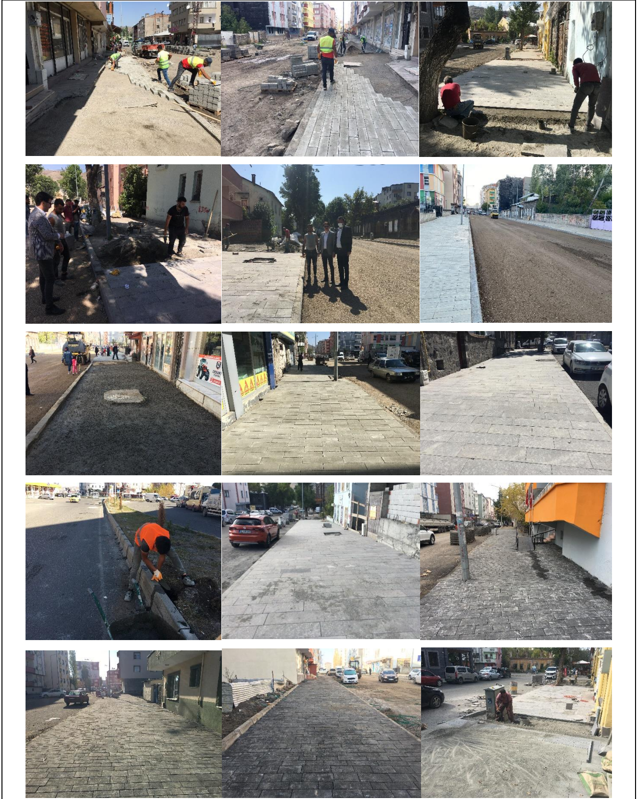
➤ 2021/306433 ihale kayıt nolu Yusufpaşa Mahallesi Halitpaşa Caddesi KaldırımYapım İşİ;
