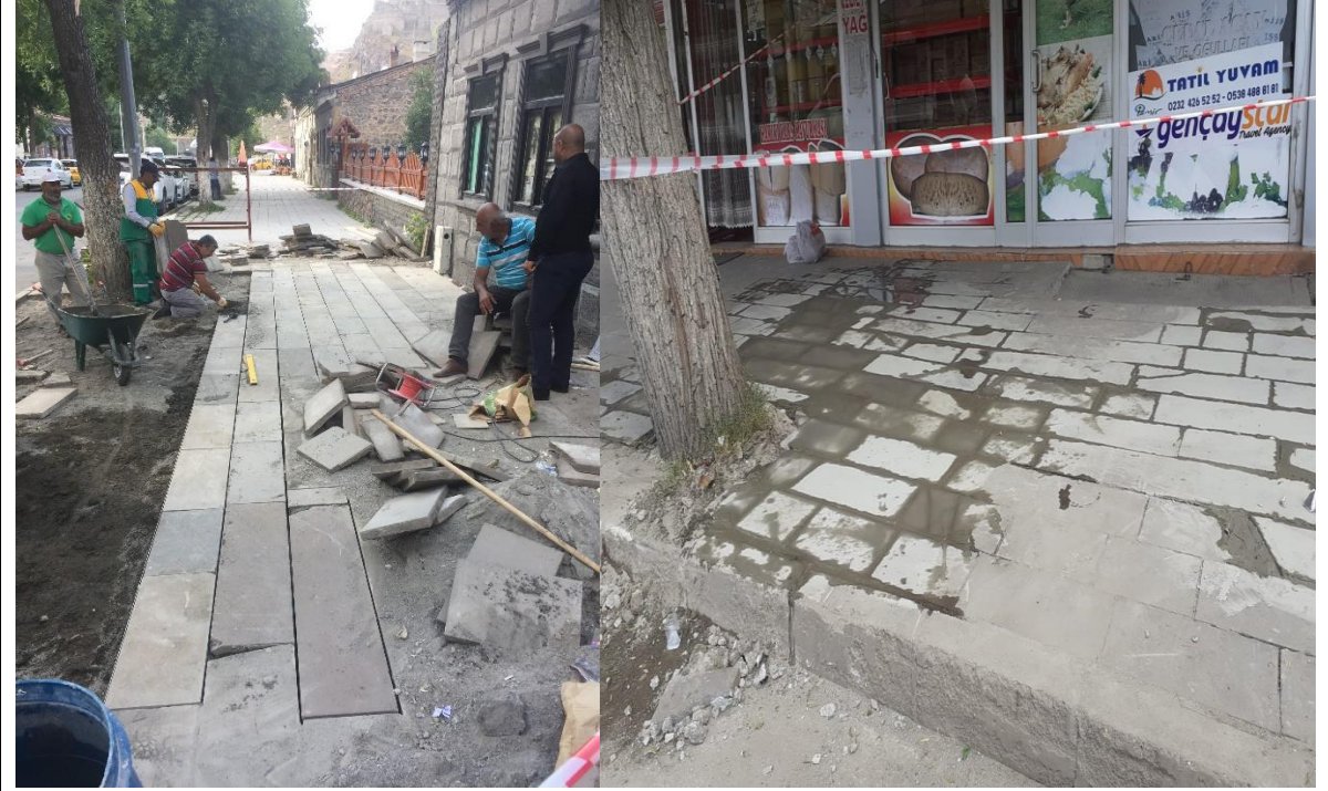
Kent Merkezi muhtelif cadde ve sokaklarında yaklaşık 500 m 2 bazalt ve andezit kaplama tamirat çalışması yapılmıştır.
