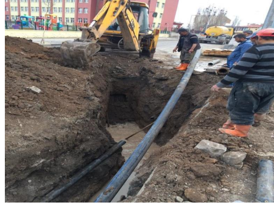
İçme suyu Arıza Çalışması
