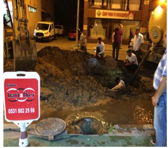
İnönü Cad .Kanalizasyon Hattı Arıza Çalışmaları
