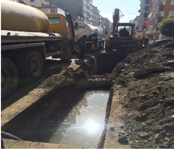
Faikbey Cad. Kanalizasyon Hattı Arıza Çalışmaları
